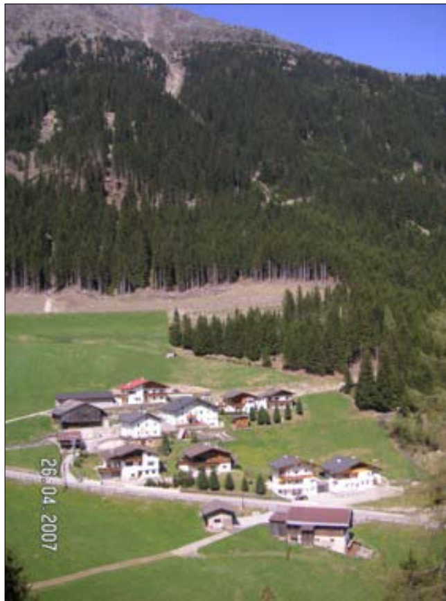
Der Weiler Kreuzlehn im Sellraintal wird von Lawinen und Steinschlag bedroht. Im Hintergrund ist der Steinschlagschutzdamm zu sehen. (Foto Forst)
